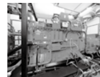
ガスエンジン+発電機▶P.19
