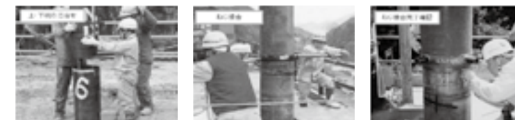
ねじ継手の接合状況▶P.23
