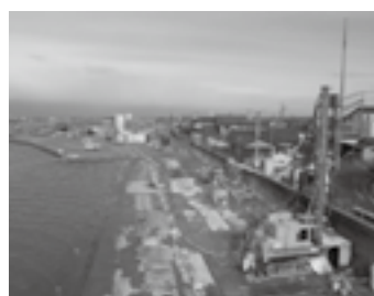
施工状況▶P. 9
